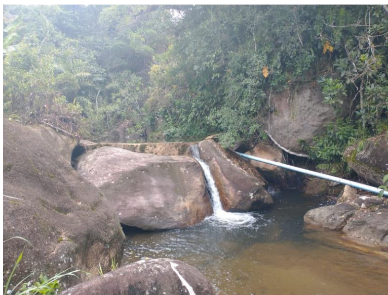
Figura 4.4 – Visita Técnica – Captação em Paraty/RJ
