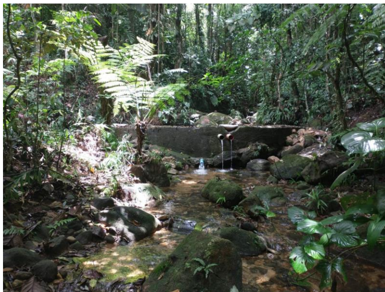
Figura 4.3 – Visita Técnica – Captação em Paraty/RJ
